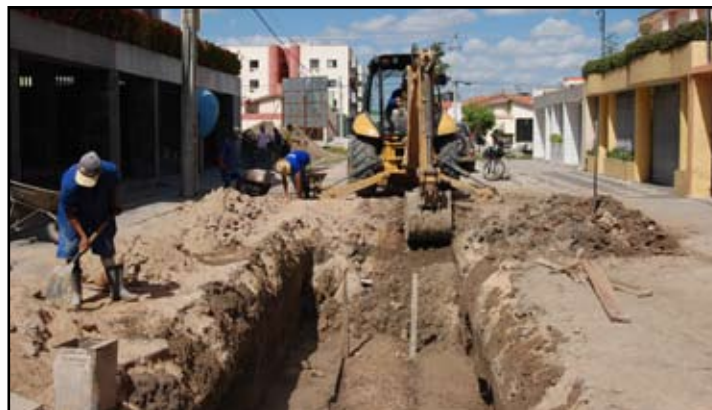
Esta obra faz parte da segunda etapa do Projeto Parque Municipal do Mucambinho
